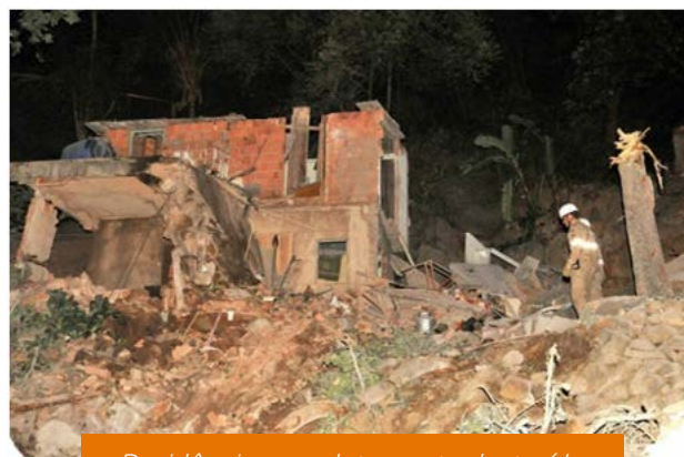
Residência completamente destruída.
